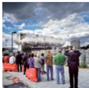
Asnières-sur-Seine. Démolition des Gentianes, 2011
