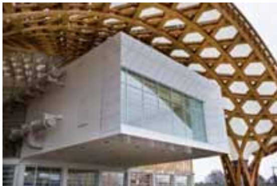
Chantier du Centre Pompidou-Metz, décembre 2009
