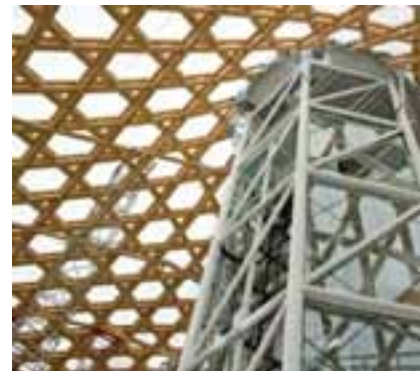
Chantier du Centre Pompidou-Metz, septembre 2009
