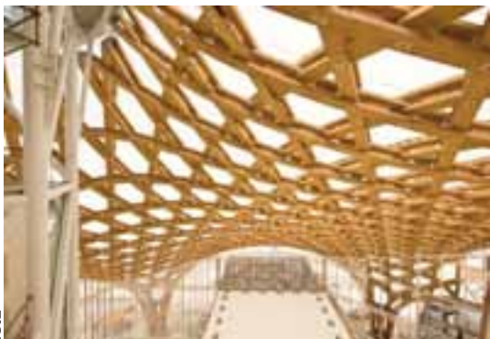
Chantier du Centre Pompidou-Metz, décembre 2009
